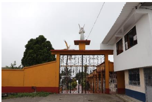
Figura 1. Imagen de la entrada principal del emplazamiento.
